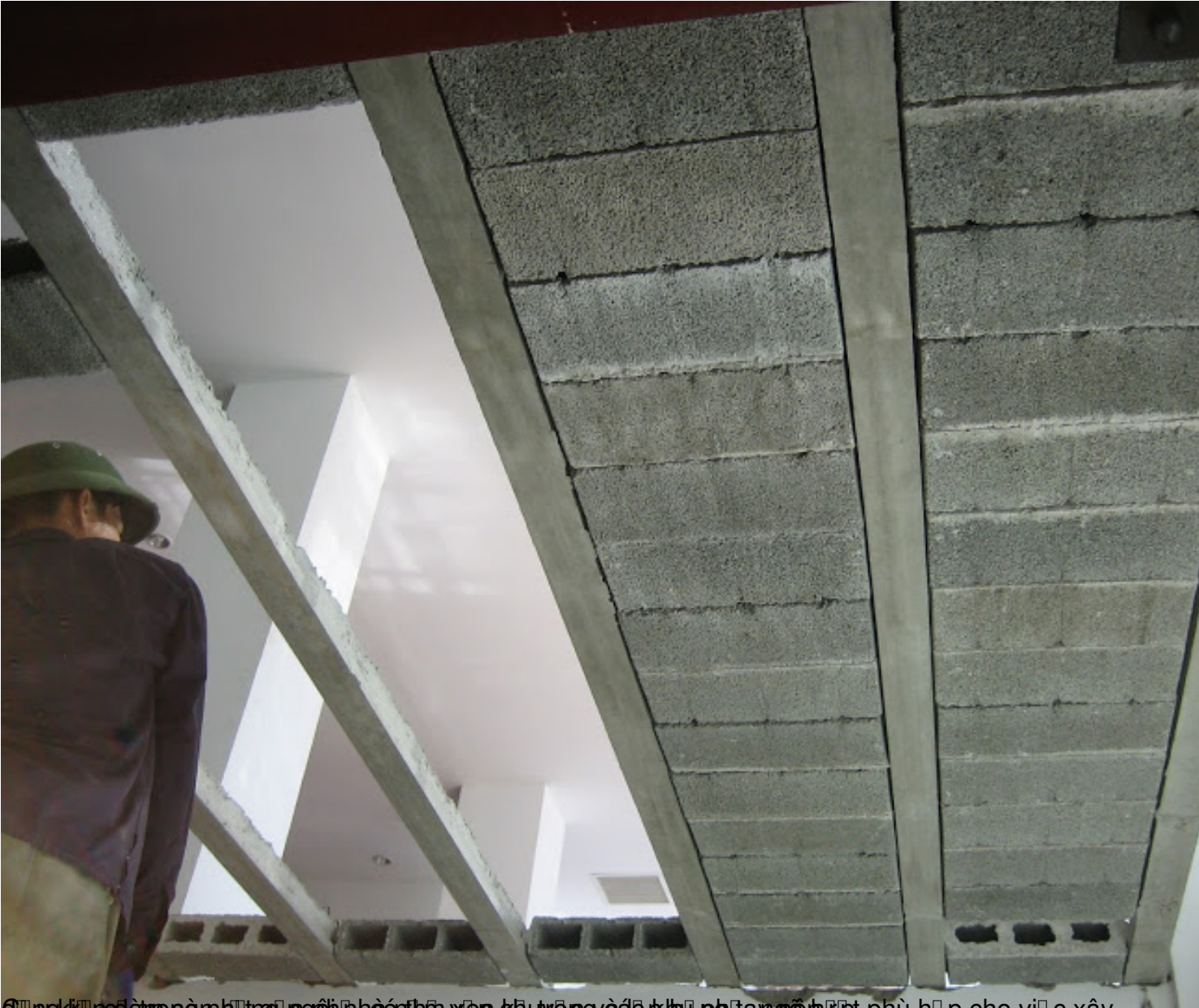
Ống kính đã được sơn mặt trong nhẵn nhụi và được lắp đặt phù hợp cho việc xây
